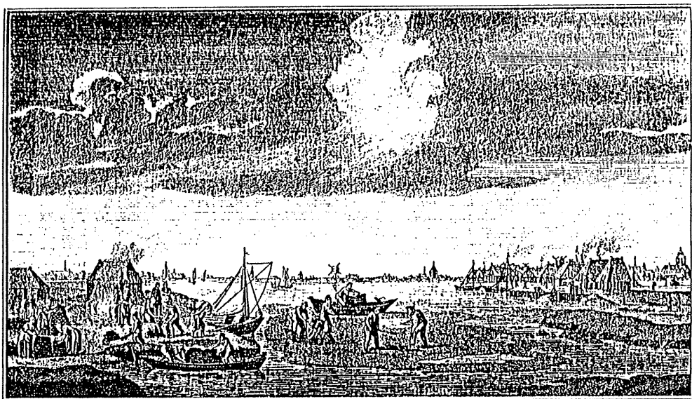
figuur 1, Op deze gravure van C. Pronk (1745) is te zien hoe de darink (veen) uit de grond wordt gespit, op hopen te drogen wordt gelegd en vervolgens verbrand. De as werd vervolgens naar zoutketen vervoerd, met zeewater vermengd en tot wit zout gestookt.
