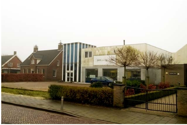
gebouwen Otte Holding - Geo-Energie
