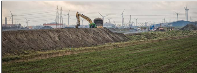
▲ De werkzaamheden aan het verkeersknooppunt bij Nieuwdorp is begonnen. © Marcelle Davidse
