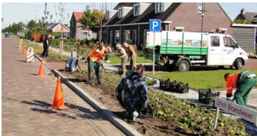
▲ participatie: onderhoud en aanleg plantsoenvak door aanwonenden
