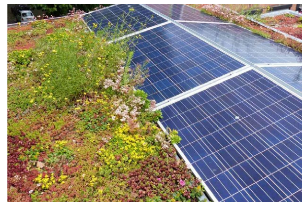
groen dak met zonnepanelen
