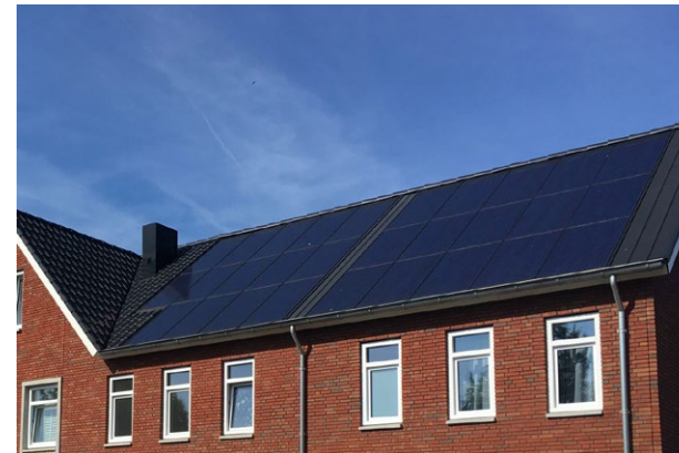
zadeldak met geïntegreerde zonnepanelen
