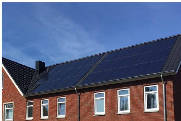
zadeldak met geïntegreerde zonnepanelen
