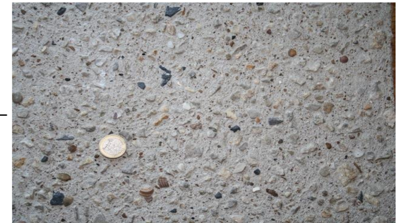
betonwand - uitgewassen beton
