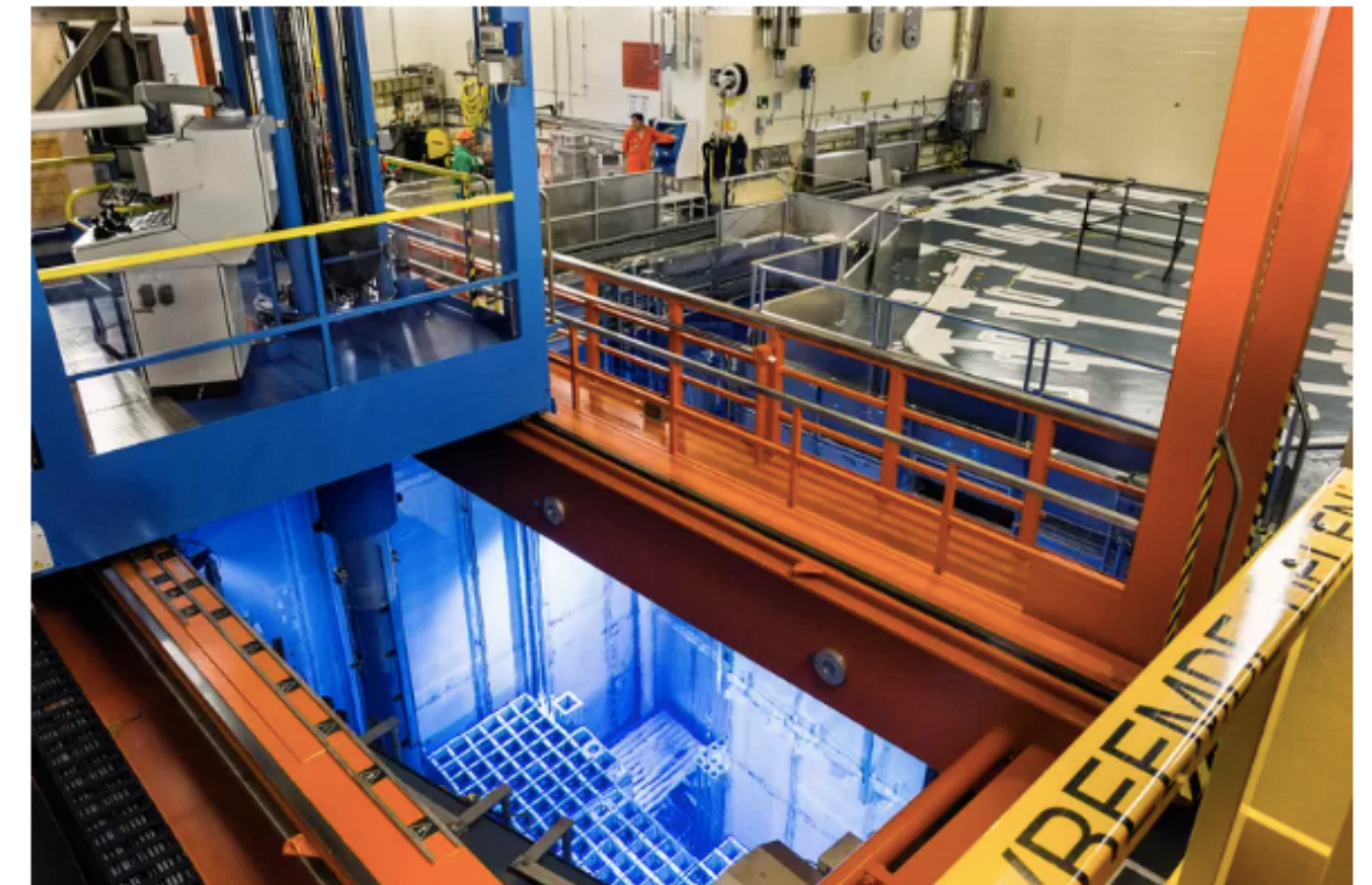
De splijtstof wordt in de kerncentrale Borsele onder water bewaard voor koeling en het tegenhouden van straling. Beeld Arie Kievit
