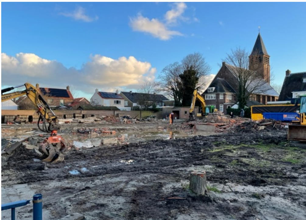
Foto: werkzaamheden tijdens sloop school. (januari 2023)
