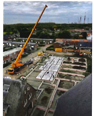
Foto: vloeren leggen, zicht vanuit de toren (oktober 2023)
