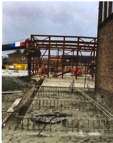
Foto: Staalconstructie Gymzaal (november 2023)
