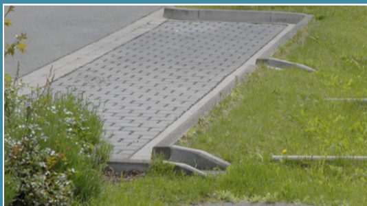
Parkeerstroken met grasdoorgroeistenen (nog afwerken met grond.)
