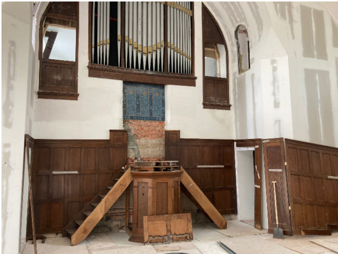
Foto's: Nieuwe kozijnen kerk en gipswerk en betimmering
