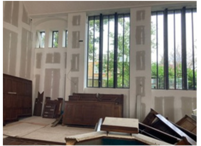
Foto's: Nieuwe kozijnen kerk en gipswerk en betimmering
