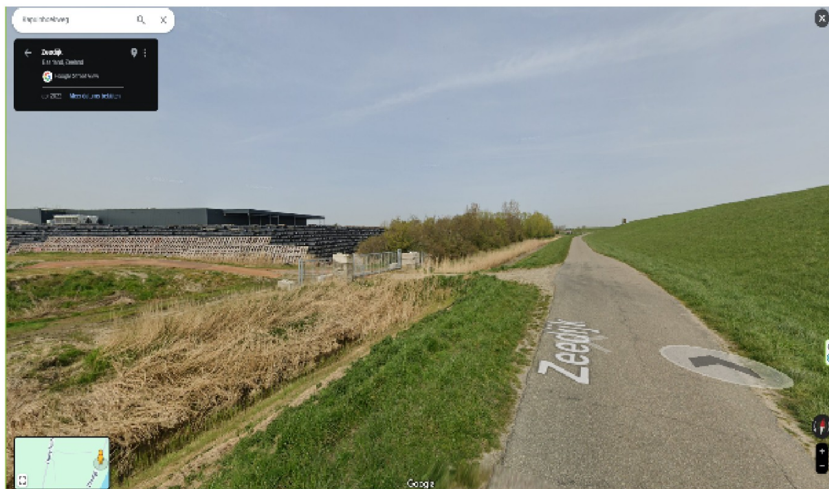
Foto 15: Overzichtssituatie Zeedijk achterzijde uienfabrieksterrein
