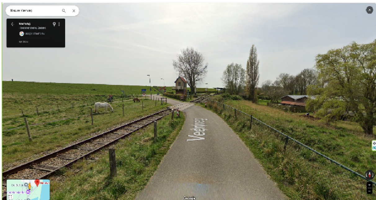
Foto 16: Situatie Veerweg t.h.v. station Hoedekenskerke
