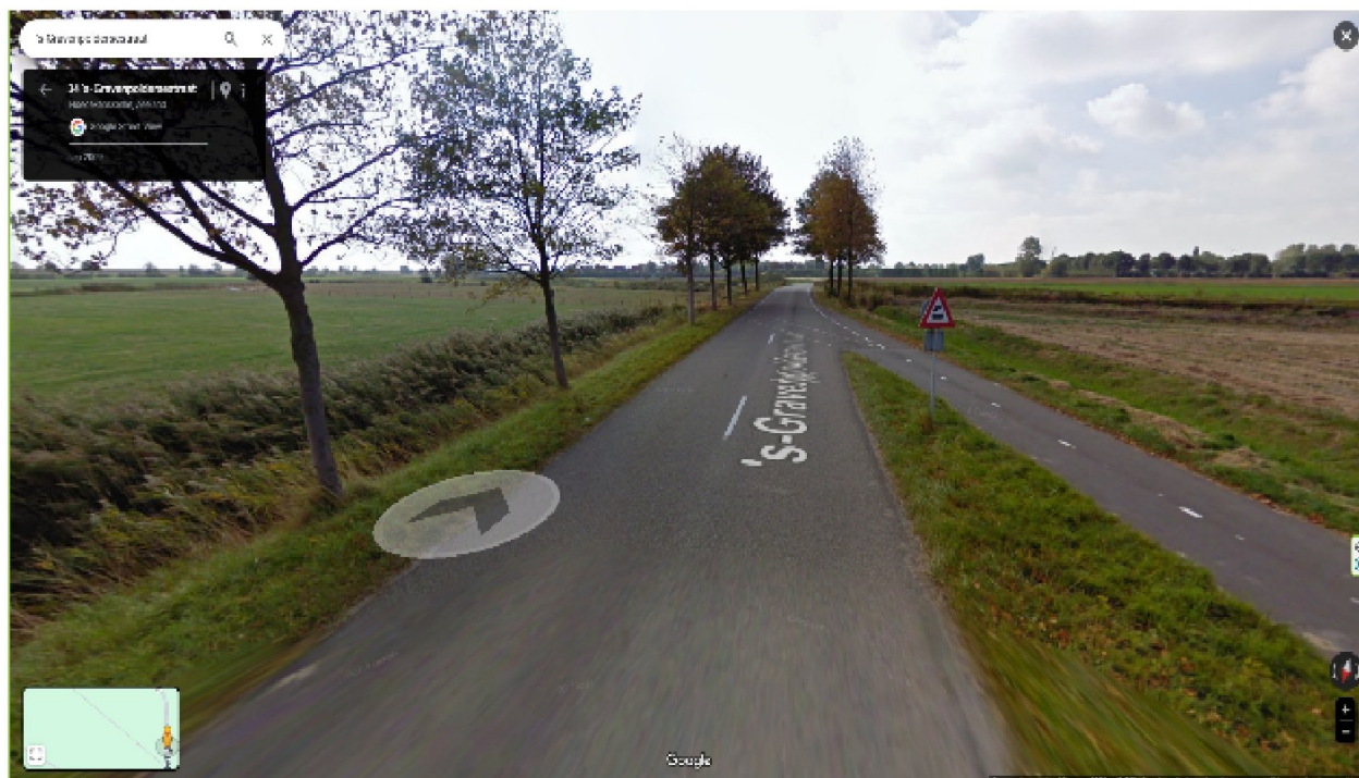
Foto 5: Overzichtssituatie 's-Gravenpoldersestraat einde fietspad t.h.v. spoorwegovergang
