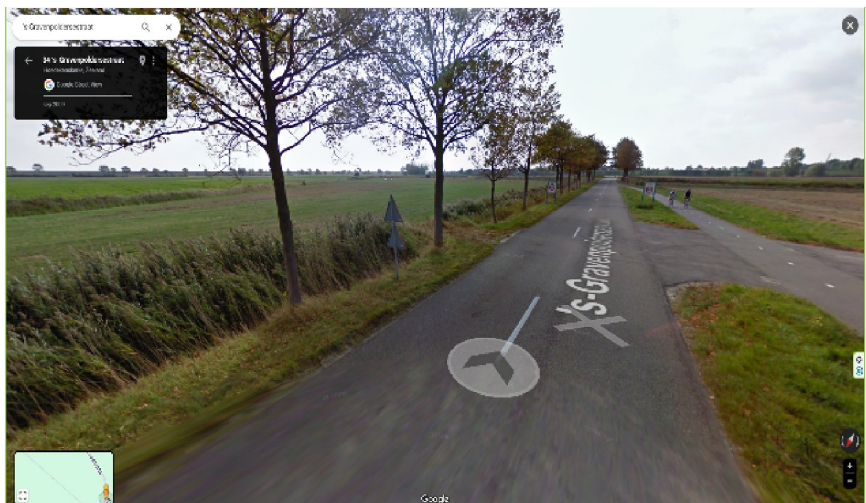
Foto 4: Overzichtssituatie 's-Gravenpoldersestraat met vrijliggend fietspad
