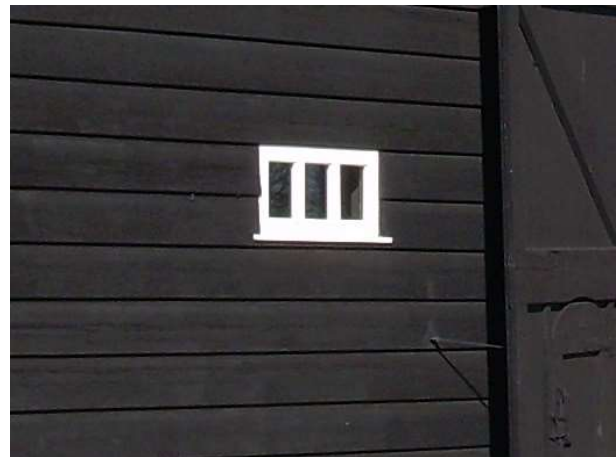
referentiebeeld kleinschalige, horizontale gevelopening in potdekselwerk deelgebied 1 (bron: Rothuizen)
